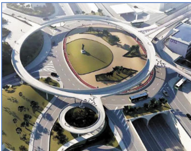
Der größte Teil der neuen Verkehrsförderung wird unter die Erde verlegt (Foto/Cedida DA)
