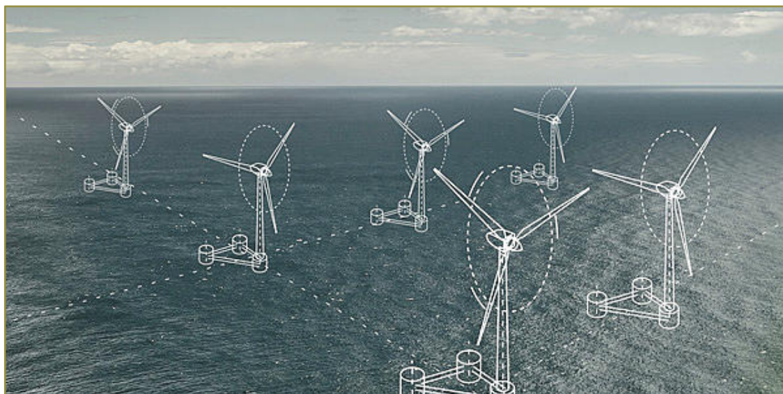
Der schwimmende Windpark kann an der Küste aufgebaut werden (Foto/Greenalia).
