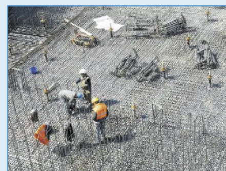
Auf dem Bau fehlt es an Rohstoffen und Arbeitskräften (Foto/cedida DA)
