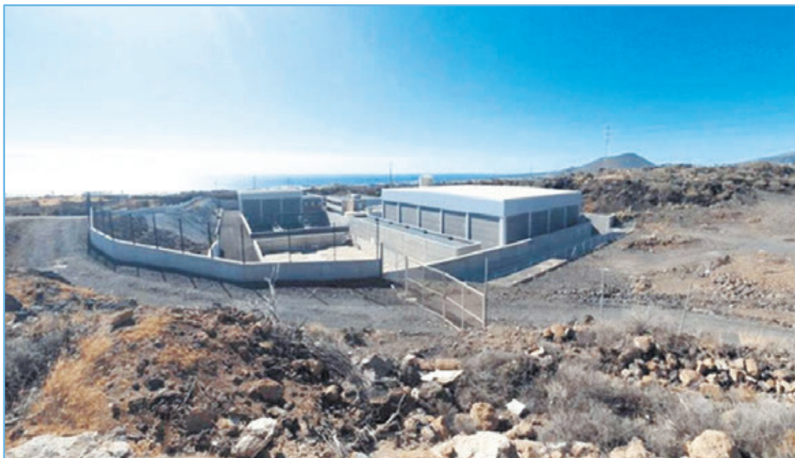
Das Abwasser erreicht die Anlage noch nicht (Foto/ArchivDA)
