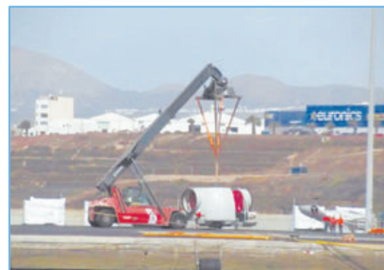
Die Bauteile liegen schon im Hafen (Foto/ArchivC7)
