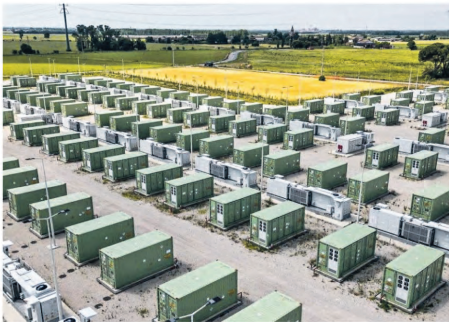
In der Anlage sollen rund 100 Containermodule installiert werden (Foto/DA)
