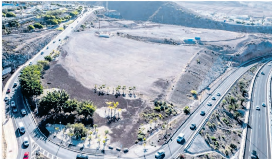
Die Vorbereitung des Geländes hat begonnen (Foto/AyAdeje)
