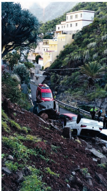
In Santa Cruz stürzte eine Stützmauer ein und beschädigte sieben geparkte Autos (Foto/BomberosTF)
