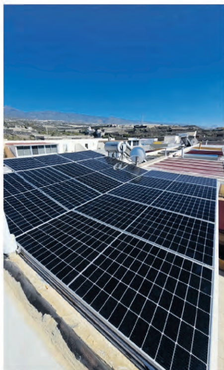
Teneriffa hat perfekte Voraussetzungen für eine Photovoltaikanlage (Foto/PhotovoltaikTeneriffa)
