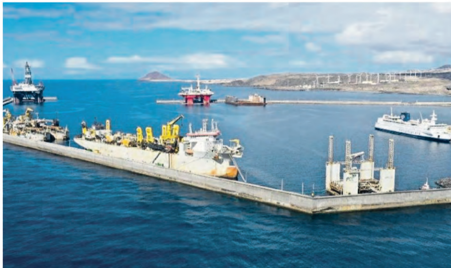
Der Hafen von Granadilla soll bis Ende 2028 voll ausgebaut sein (Foto/ArchivDA)
