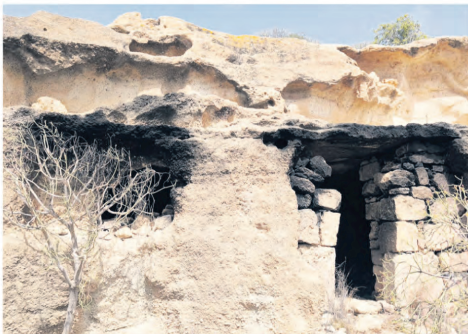
Der Brand hat sichtbare Spuren hinterlassen (Foto/ArchivDA)
