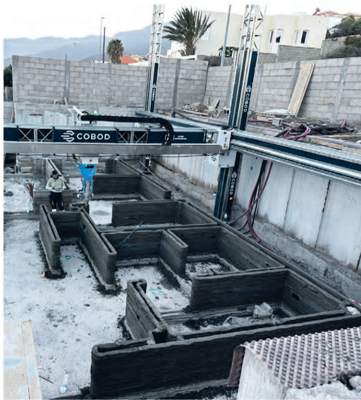
Innerhalb weniger Tage steht ein ganzes Haus (Foto/TopConstruction)
