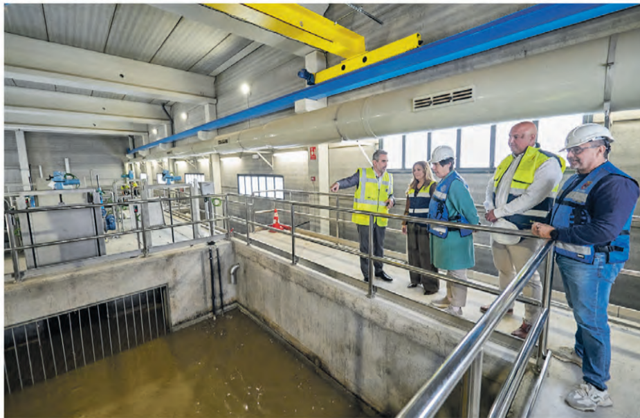
Die ersten Ortsteile werden bereits über die Anlage geklärt (Foto/CabTF)
