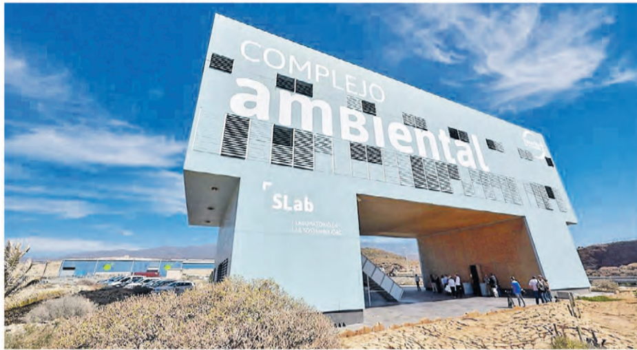
Die Anlage in Arico soll erweitert werden (Foto/CabTF)
