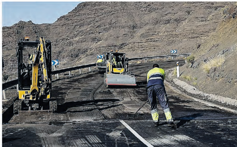
Innovativer Straßenbau auf Recycling-Basis (Foto/ArchivC7)
