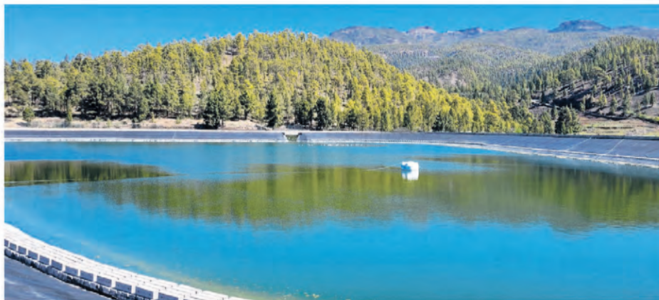
Wassermangel hat auf Teneriffa zur Perfektionierung der Staubecken geführt (Foto/ArchivSV)
