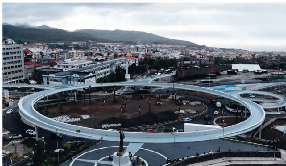
Die Fußgänger gehen sicher über den Autos über die Kreuzung (Foto/ArchivDA)
