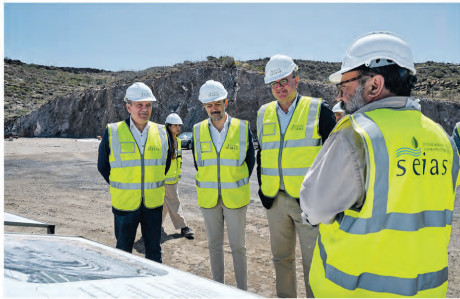
Baustellenbegehung vor Ort (Foto/CabTF)
