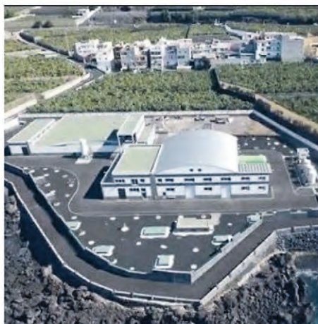
Die Entsalzungsanlage ist voll in Betrieb (Foto/CabTF)
