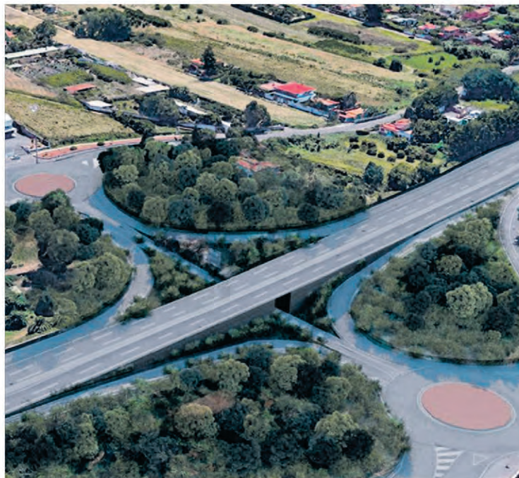
Dritte Fahrspur für Guamasa (Foto/CabTF)
