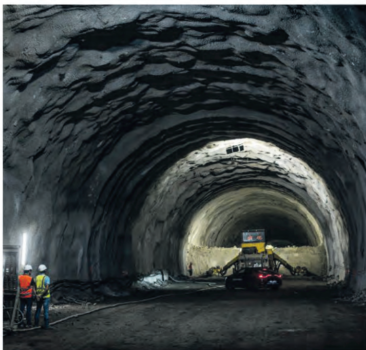
Dritte Fahrspur für Guamasa (Foto/CabTF)
